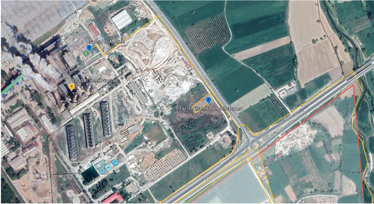
Fotoğraf 23 Ana Pompa İstasyonu Konumu
