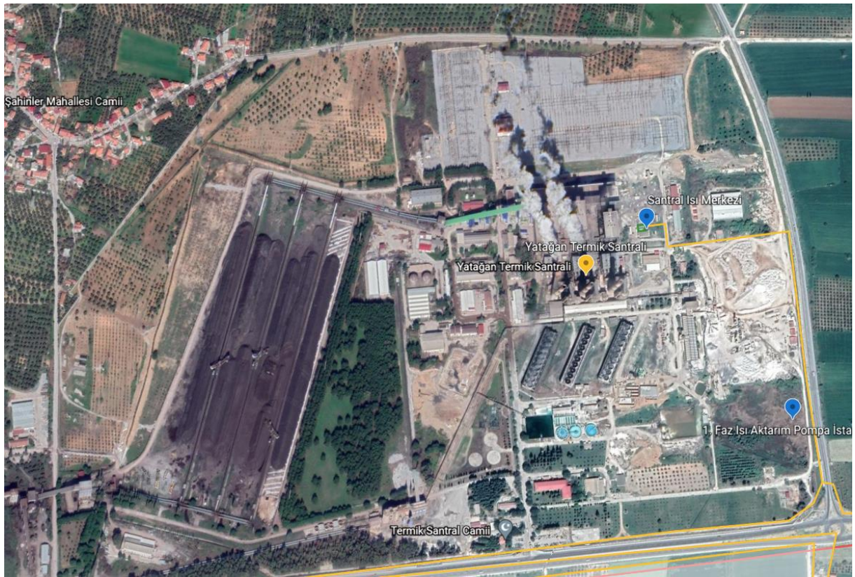
Şekil 4 Yatağan Termik Santrali
