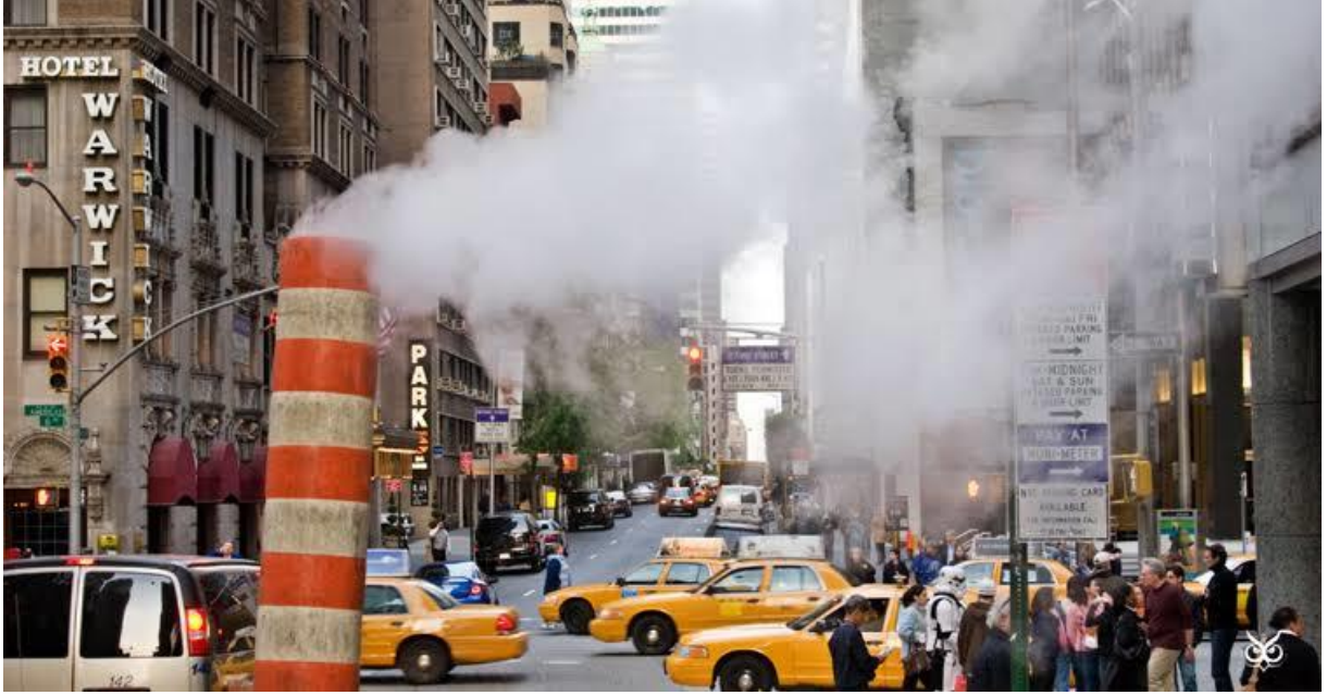
Fotoğraf 6 New York Buhar Kaynaklı Bölgesel Isıtma Sistemi
