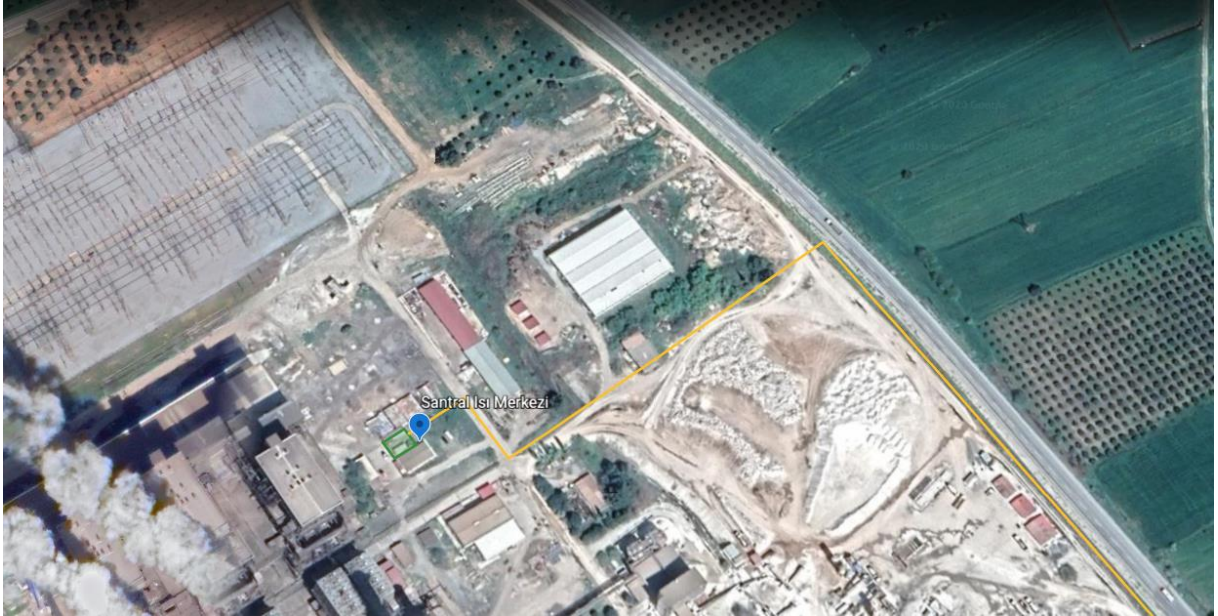
Şekil 6 Santal Isı Merkezi
