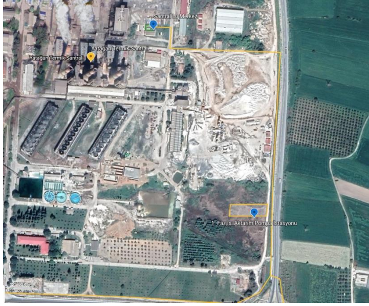
Fotoğraf 1 Ana Pompa İstasyonu ve Ana Nakil Hatları
