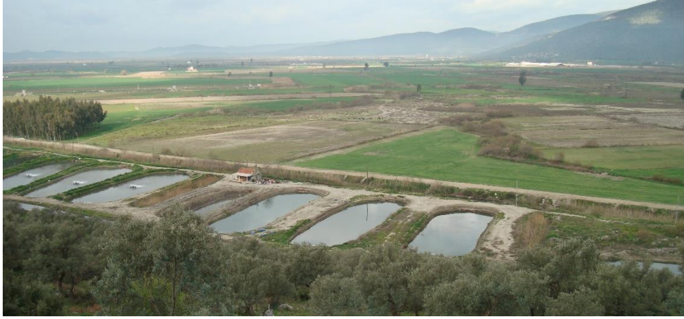
Şekil 11. Adaptasyon Tesis Binası ve Toprak Havuz İşletmesi
