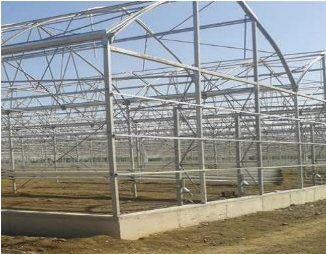
Şekil 1.18. Çevre Temel ve Yan Perde Betonu
