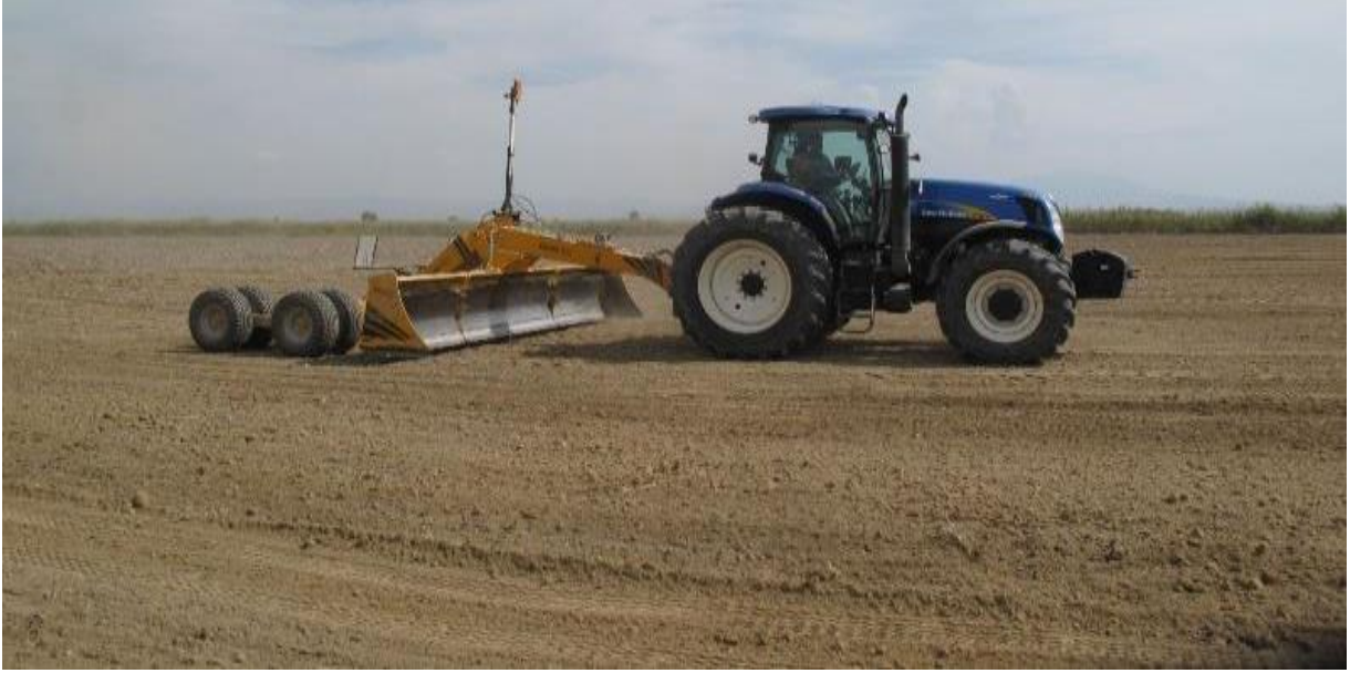
Şekil 1.15. Sera Alanı Arazi Tesviyesi
