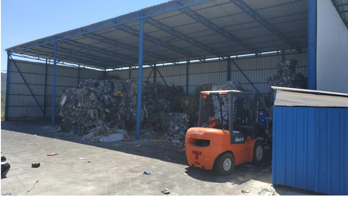
Fotograf 2 Fethiye Katı Atık Düzenli Depolama Tesisi
