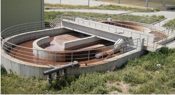
Çamur Yoğunlaştırma Havuzu
