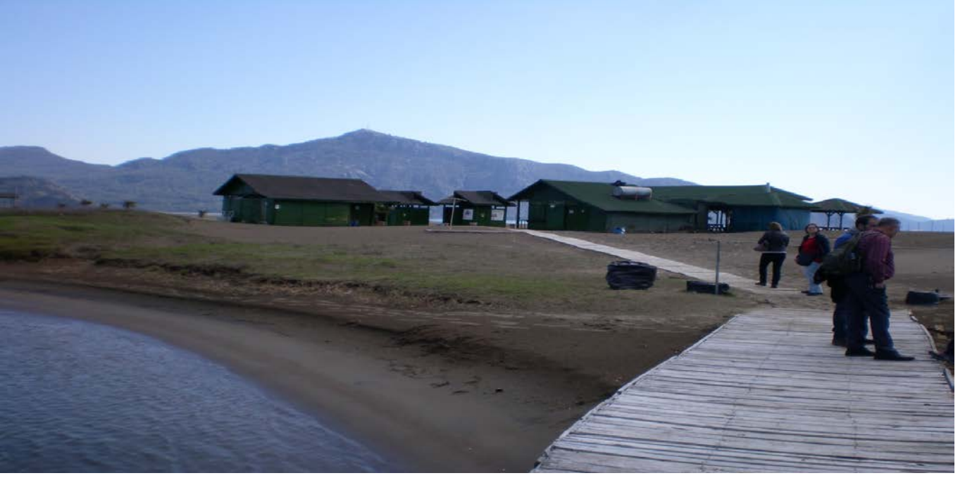
KUZEY TESİSLERİ İSKELEDEN GÖRÜNÜŞ
