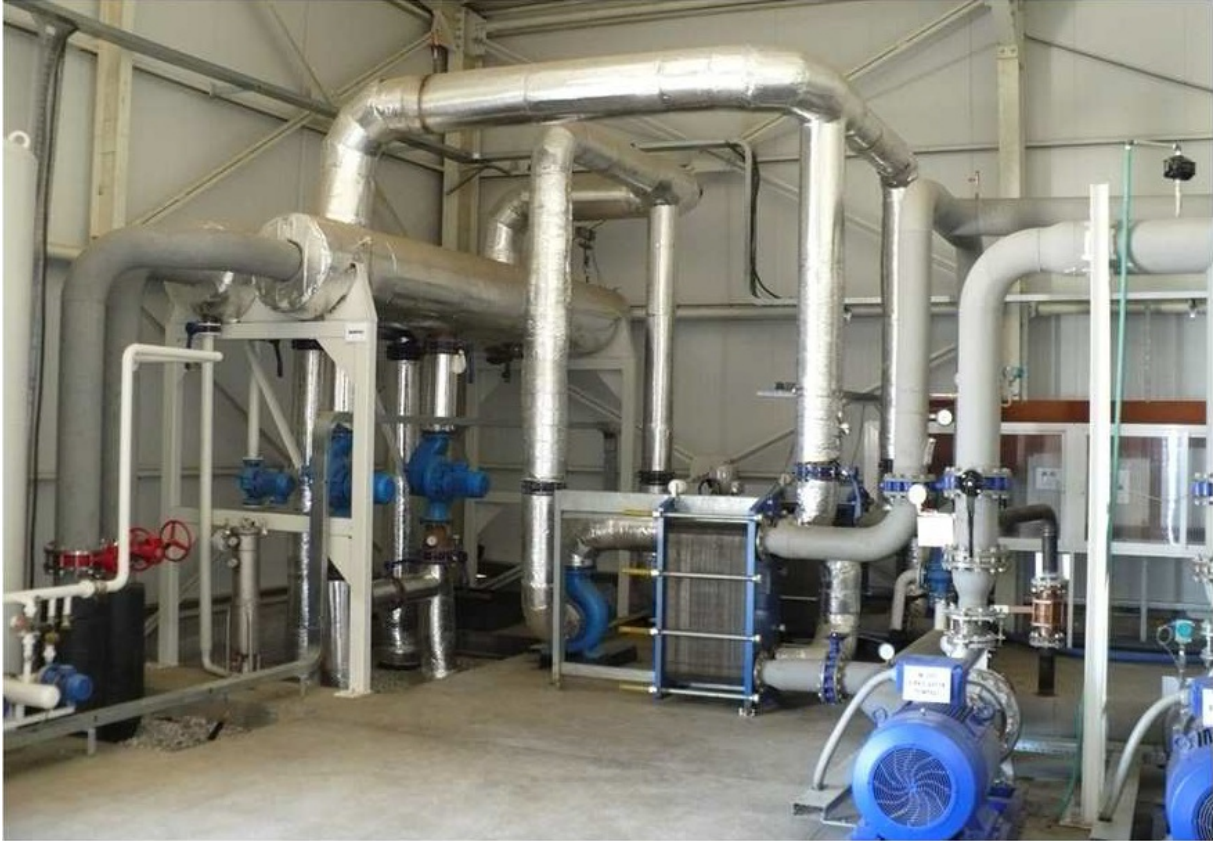
Resim 11 Sera İşletmesinde Jeotermal Isıtma Tesisatı
