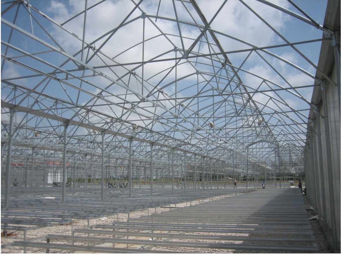
Resim 3 Sera Konstrüksiyon Montajı
