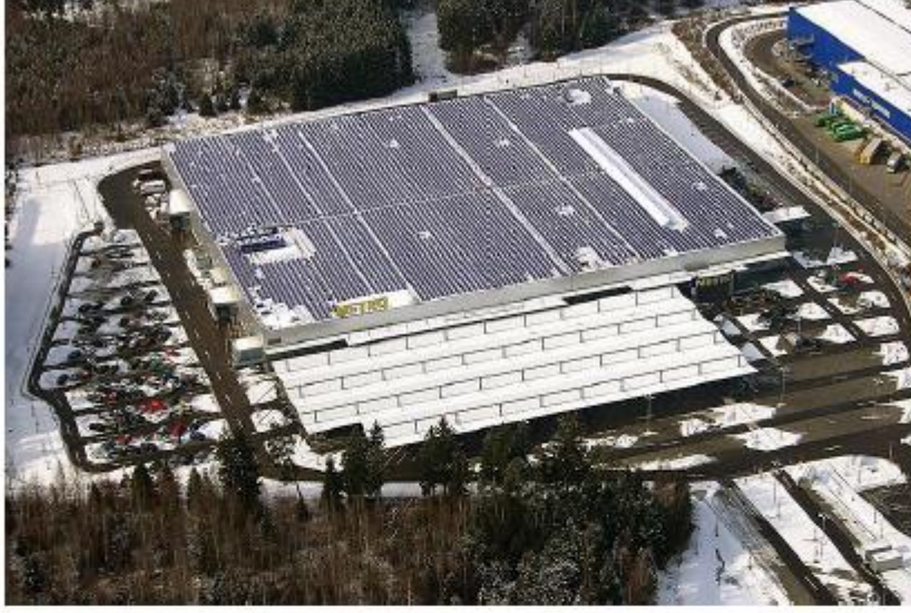
ALMANYA METRO GROSSMARKET I MEGAWAT ÇATI KURULUMU
