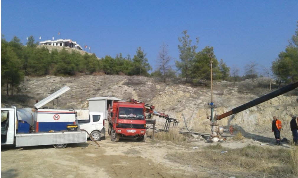
Göl-2 Kuyusu Statik Sıcaklık ve Basınç Ölçümleri
