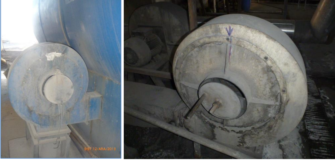
Gereğinden büyük seçilmiş kazan taze hava fanları. Klepe ile kısma uygulanmış.
